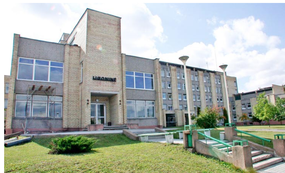
Ligoninės pastatas buvo senos statybos, todėl išlaidos šilumai buvo didelės. Po renovacijos jos sumažėjo 40 proc.
